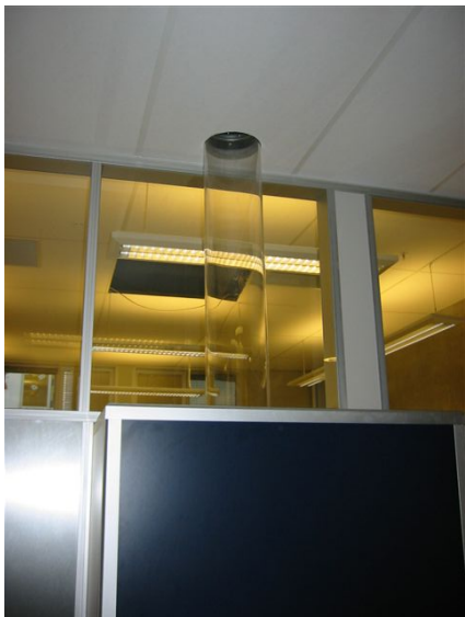
Bilde 13: Detalj. Ventilasjonsskanal
