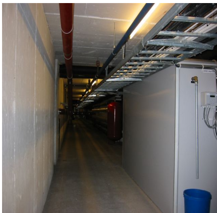
Bilde 10: Detalj. Akkumuleringstank for solvarme plassert i kulvert
