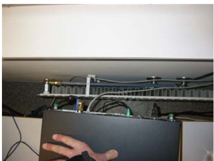
Bilde 17: Detalj. Rørføring til radiator
