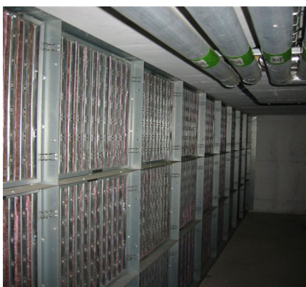
Bilde 9: Filtervegg ventilasjon
