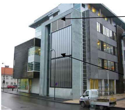
Bilde 8: Luftinntak solfangerpanel
