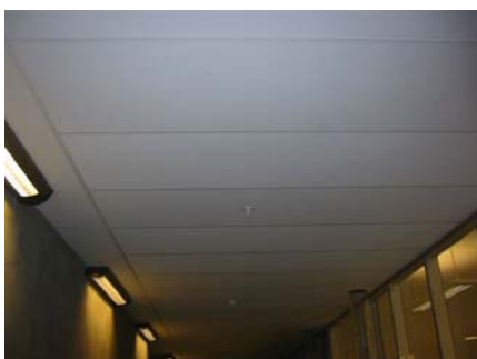
Bilde 14: Detalj. Himlingsplater i korridor
