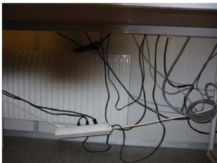
Bilde 16: Detalj. Kabler under vindu
