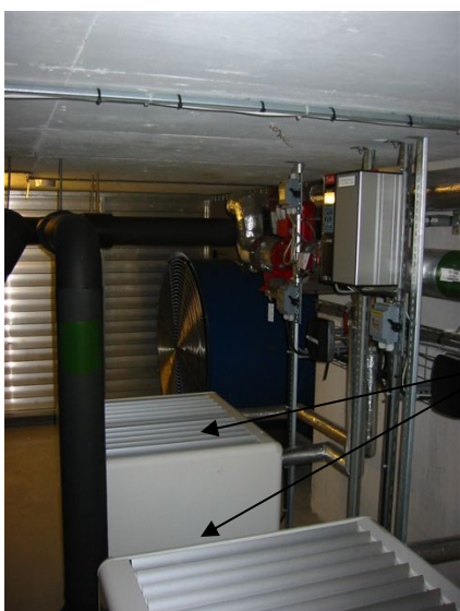
Bilde 11: Detalj. Aerotempere (aerotemper=luftvarmer)
